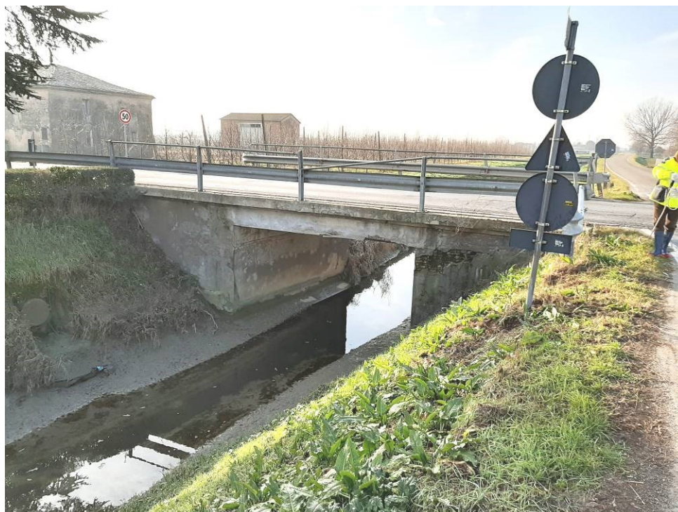
2. PONTE SCOLO FOSSATONE SP 35 PK 1+798 A S.M. FABRIAGO ;
