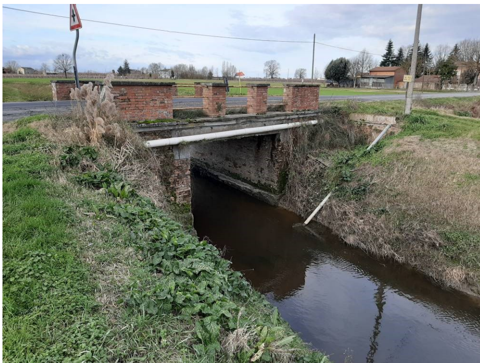
1. PONTE SCOLO ARGINELLO SP 17 PK 2+937 A MAIANO ;
