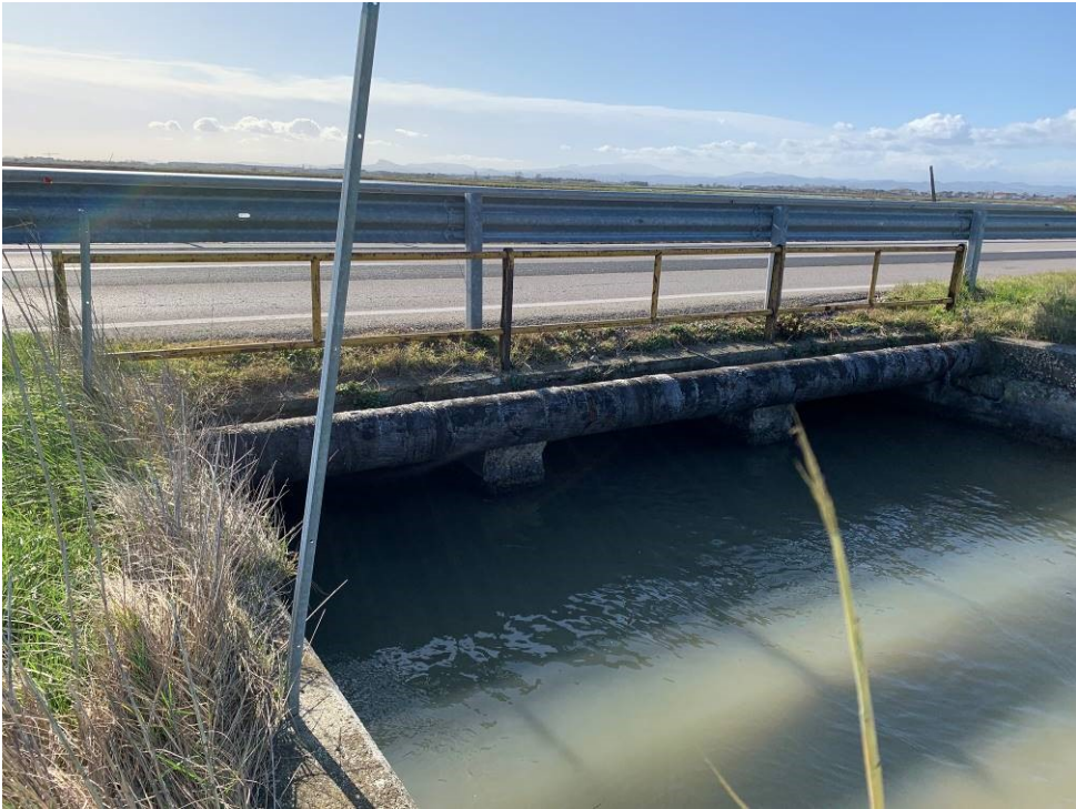
5. PONTE SULLE SALINE SP 6 PK 4+080 A VILLA INFERNO ;
